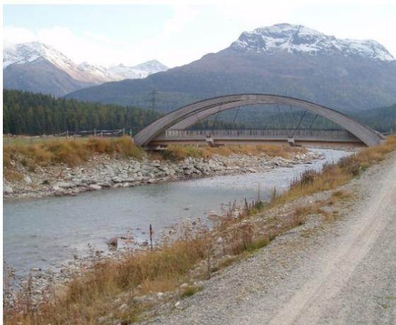
Fig. 84 Immagine per il rilievo di un ponte.
