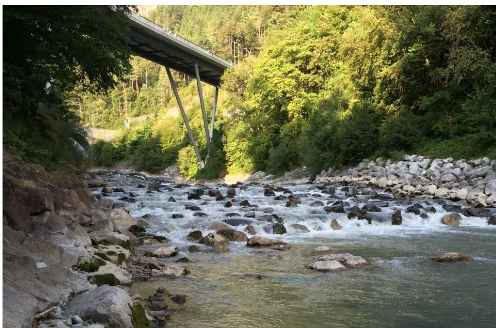
Fig. 8 Esempio di rampa di blocchi posati alla rinfusa.
